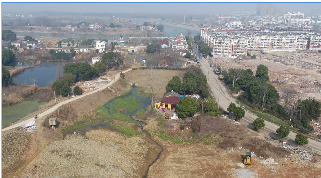
老人桥排涝站渠道现状
