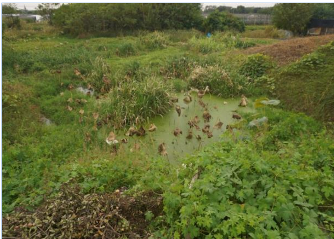
罗保圩春江路渠杂草丛生、淤积严重
