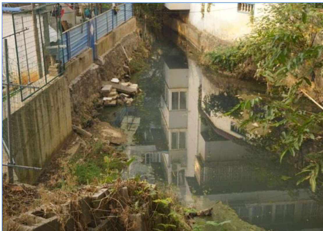
城南河水厂路至世纪大道段河道水环境差，两岸建筑侵占河道
